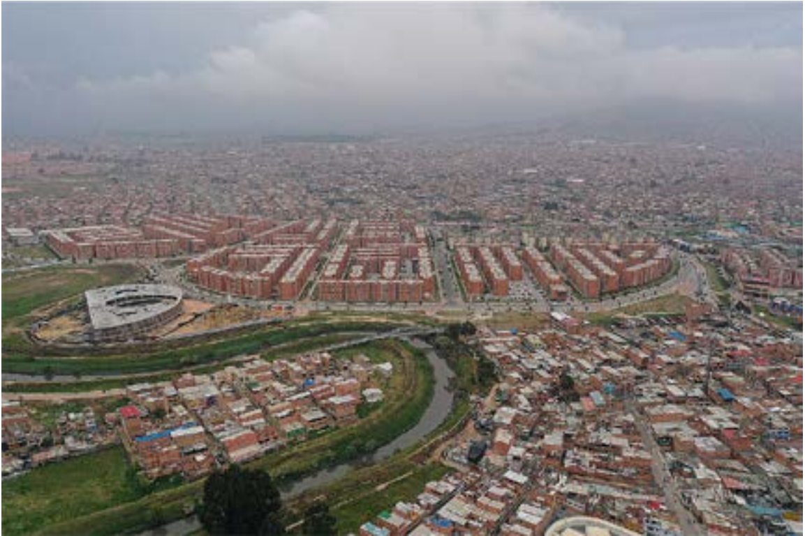
Foto 2. Desarrollo urbano en Bosa, alrededores de la Ciclorruta Alameda El Porvenir, Plan Parcial San José de Maryland, futura Avenida San Bernardino. Archivo del CIMB 2019
